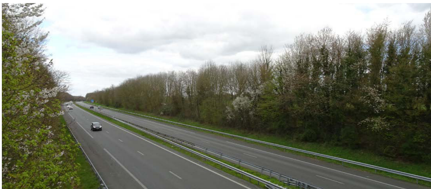
PHOTO 101 : LES ARBRES ET LES TALUS QUI BORDENT L'AUTOROUTE A10 FERMENT LES VUES VERS LA ZIP
