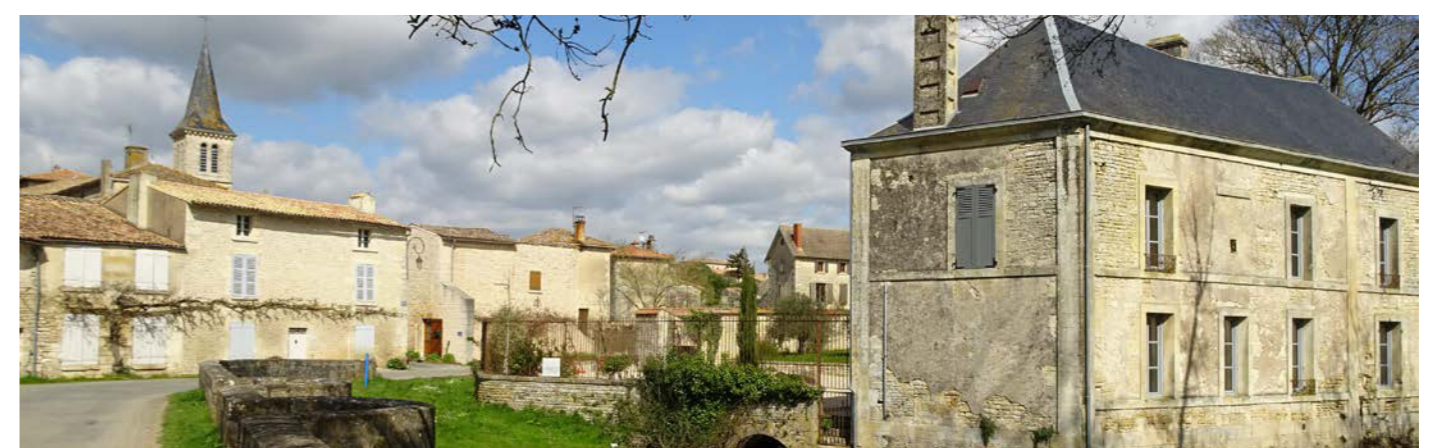
PHOTO 120 : LE BÂTI TEND À LIMITER LA VISIBILITÉ DE LA ZIP MAIS UN RISQUE D'ÉCRASEMENT EST PRESSENTI DU FAIT DU POSITIONNEMENT DU BOURG EN CONTREBAS DU SITE D'IMPLANTATION
